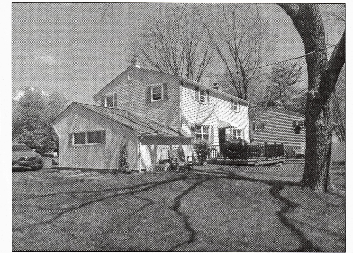
EXISTING CONDITIONS PHOTOS N.T.S.
